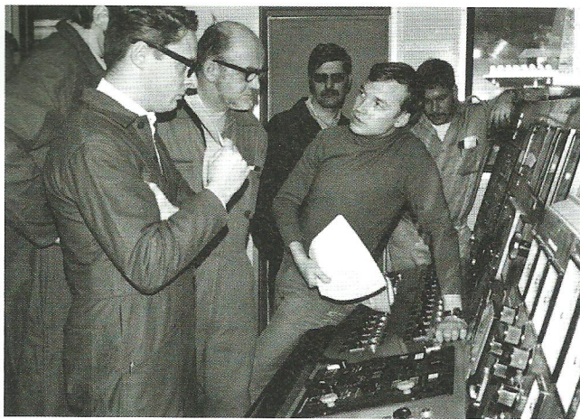
Test av kontrollsystem för turbinmaskineriet.
