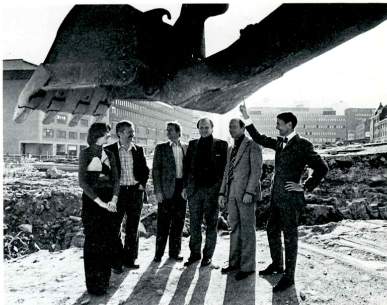
Här står Matts Larsson med några av sina medarbetare under armen på en grävskopa en tidig morgon sommaren 1975. Husbygget har påbörjats.
