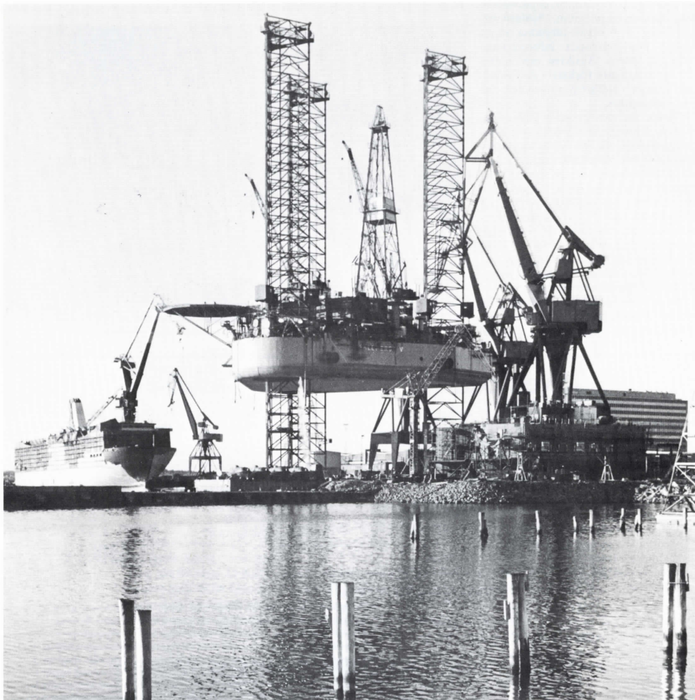
Salenergy V på Arendal – Göteborgs högsta byggkonstruktion.
