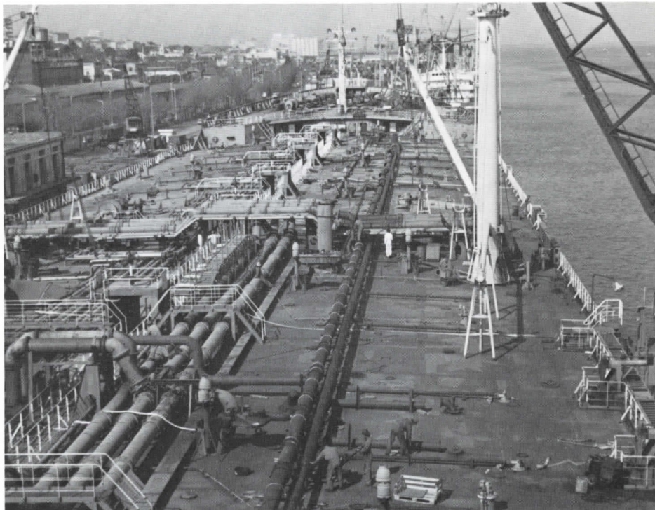
M/t South Angela – Installationen av IGS- och COW-systemen på däck närmar sig fullbordan vid Navalconsultes kaj i Lissabon.
