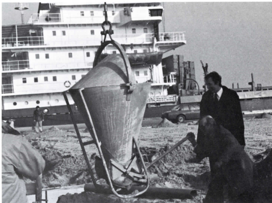
Vid månadsskiftet februari/mars började man gjuta bottenplattan till kylhuset. På bilden ses chefen för Sealane, Mr. K Tammes, som tillsammans med hamndirektören i Delfzijl and Eemshaven, Mr. C van Elderen, begjuter grunden med den första omgången betong.
