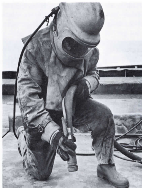
Underhållsarbetet är viktigt. Här sand- blästras lastluckorna innan de målas
