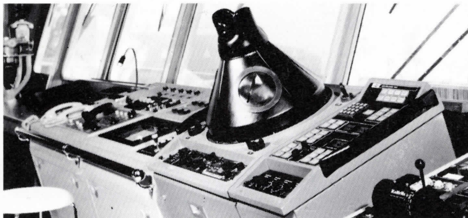
Fr v radaranläggningen med kollisionvarsningssystem samt manöverenheter för framdrivningsmaskineriet.
