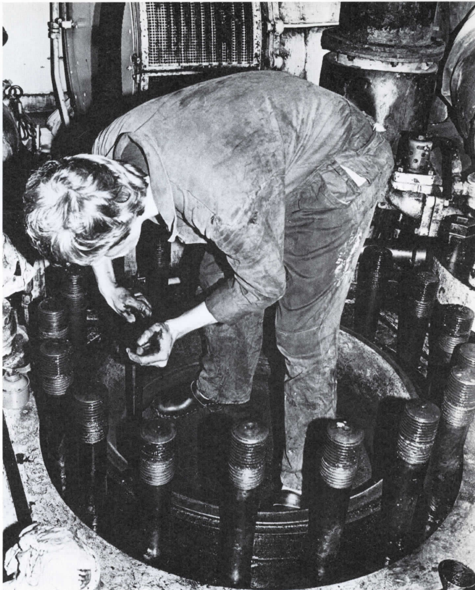
Varje arbetsmoment kräver erfarenhet och kunnande. Reparator Anders Käck under arbete vid kolvhalning i Arawak.
