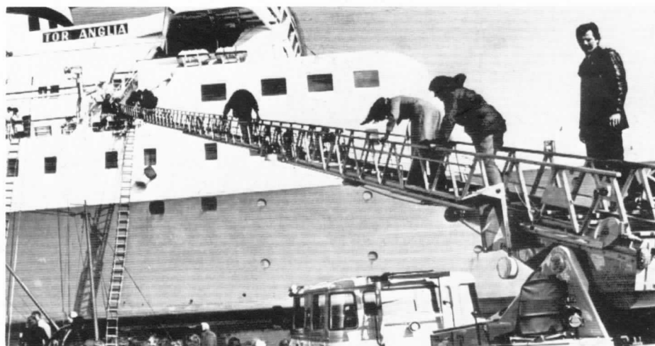
Passagerare tar sig iland via en brandstege.
