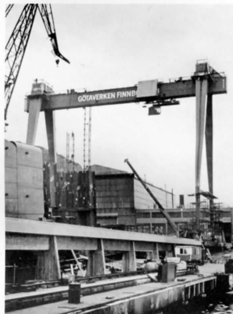
Den nya bockkranen är anpassad till varvets nybyggnadsbehov
