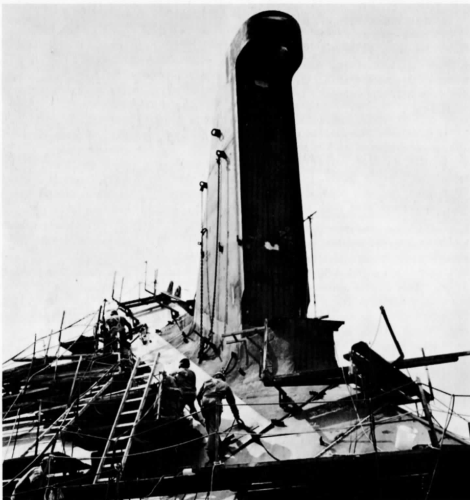
Bilden visar en sektion av akterstaven med roderhorn och rodermalja.
