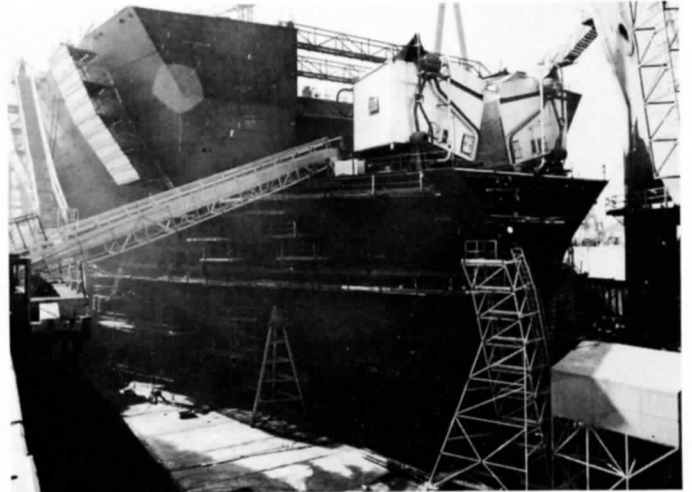
Turbinerna till huvudmaskinen har installerats och pannorna lyfts in.
