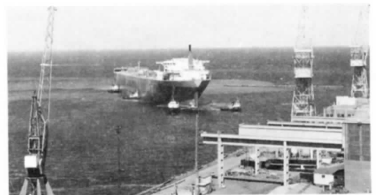
Fartyget har dockat ut. Vid utrustningskajen avslutas återstående installationsarbeten. Maskineriet provköres. Två månader senare levereras det färdiga fartyget.
