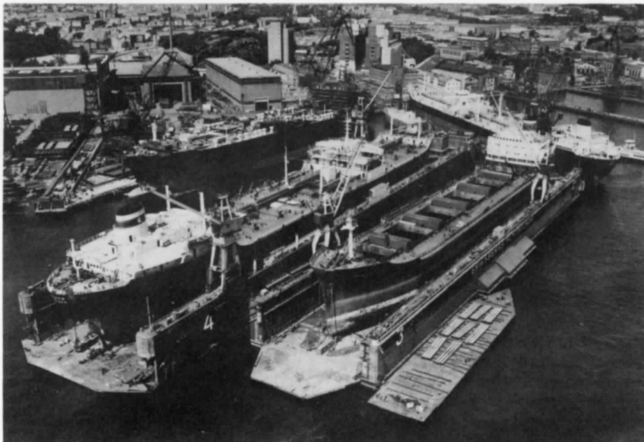
Vy över Eriksbergs reparationsenhet. I mitten ses 4:ans flytdocka som kan ta 80 000-tonnare och som skall flyttas över till Götaverkens reparationsvarv.
