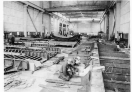
Interiör av skrovhallen.
