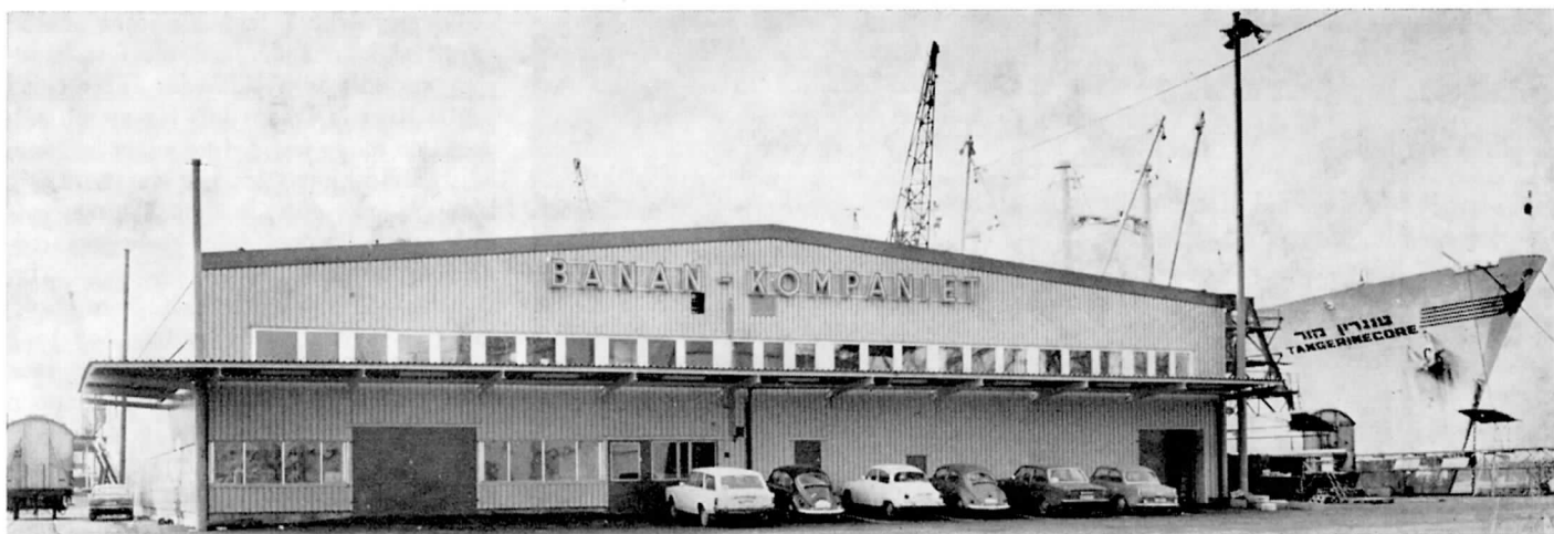
Banan-Kompaniets nya anläggning
