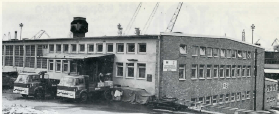
Salénrederiernas Centralförråd i Kajskjul 46, Majnabbehamnen, Göteborg.
