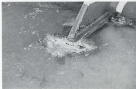
Färgen slogs bort och däckets gav vika under den hårda behandlingen. Läckan här har tätats med talg.
